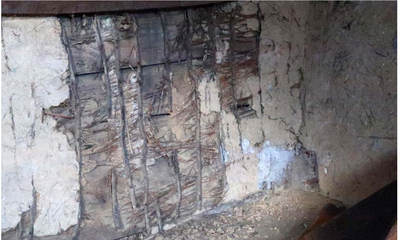
Kampstraße 15, Dachgeschoss Anbau, Nordostecke der Kammer mit Lehmputz
