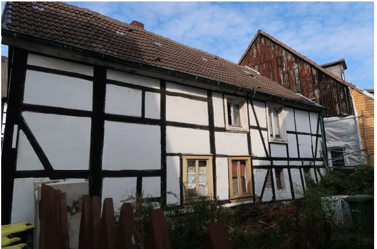
Kampstraße 15, Rückwand (Südseite). Links der Ursprungsbau, rechts die das Haus verlängernde Erweiterung
