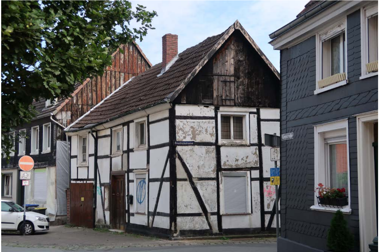
Abb. 2. Haus Kampstraße 15 an der Straßenecke Kampstraße/Friedrichstraße mit den Nachbarhäusern Nr. 13 (links) und 17 (rechts). Blick von Nordwesten aus der Kampstraße. Nach vorn der Ursprungsbau, nach hinten in der Breite des Garagentors die Hausverlängerung des 19. Jahrhunderts.
